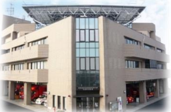
消防本部・松阪中消防署
