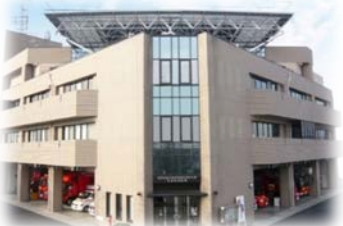
消防本部・松阪中消防署
