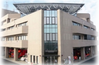
消防本部・松阪中消防署
