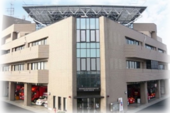
消防本部・松阪中消防署
