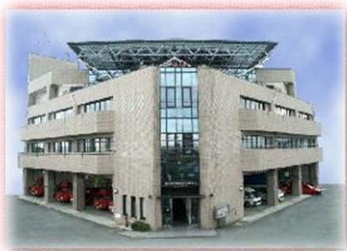
消防本部・松阪中消防署
