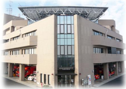
消防本部・松阪中消防署
