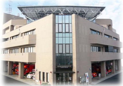
消防本部・松阪中消防署
