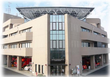
消防本部・松阪中消防署
